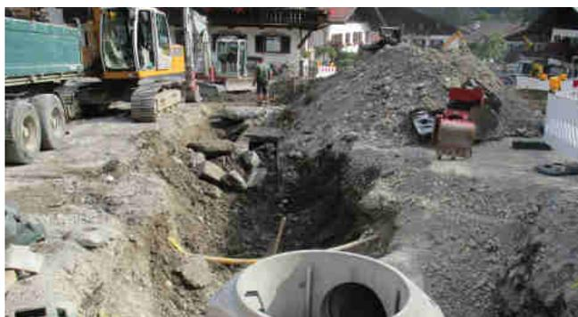
Inbetriebnahme der neuen Verrohrung des Alepbachs, Ab- bruch der bestehenden Verrohrung
